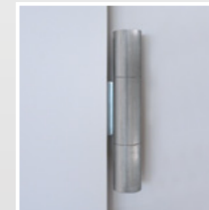
Die Rollenbänder werden ohne Dichtungsunterbrechung montiert.
